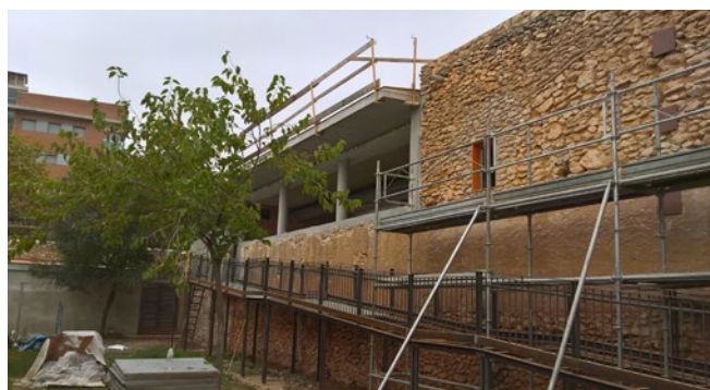
Detall de les obres del futur Centre Ocupacional i Centre de Dia, el novembre del 2016
